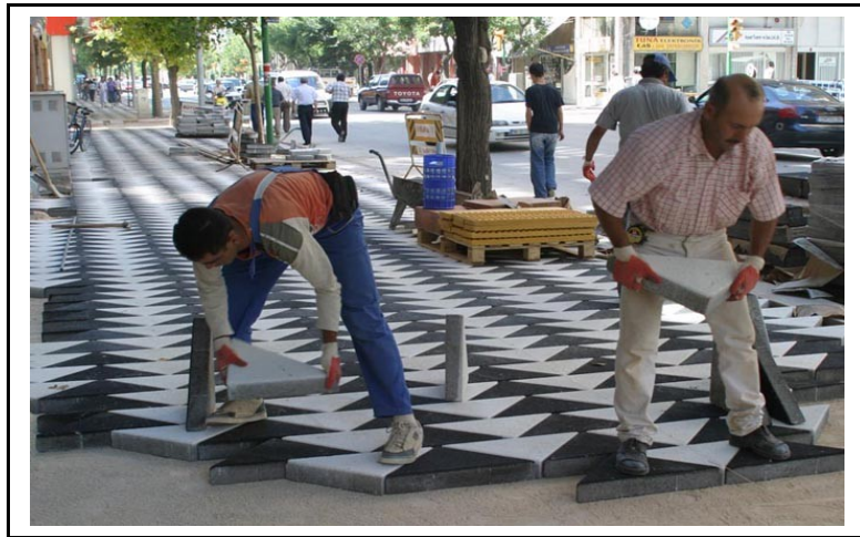
Şekil 4.57 Renkli döşeme uygulaması (URL-8 2010).
