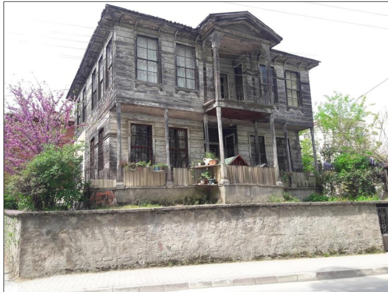
Şekil 4.45: Ahşap yapı örneği (Orijinal, 2018).
