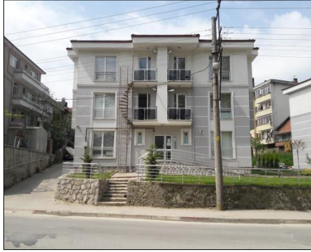
Şekil 4.40: “İyi” durumdaki yapı örneği (Orijinal, 2018).
