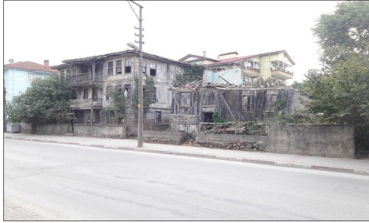
Şekil 4.47: Yıkılmış tescilli yapı örneği (Orijinal, 2018).
