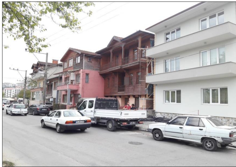
Şekil 4.16: Çalışma alanında yer alan betonarme yapı örnekleri (Orijinal, 2018).
