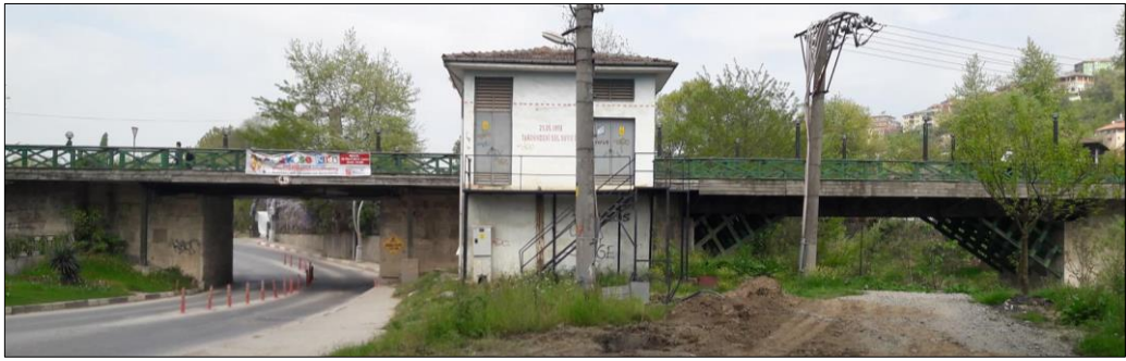
Şekil 4.25: İşaret ögesi, Orduyeri Köprüsü (Orijinal, 2018).
