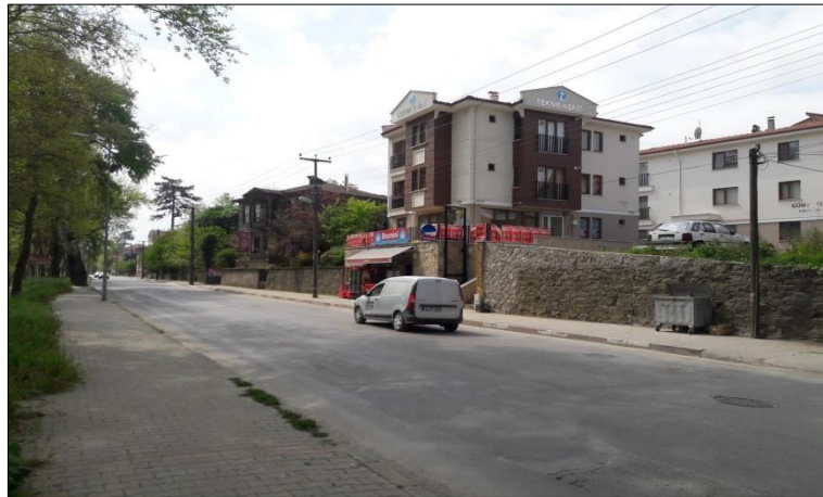
Şekil 4.48: Geleneksel dokuya uyumlu olmayan yapı örneği (Orijinal, 2018).
