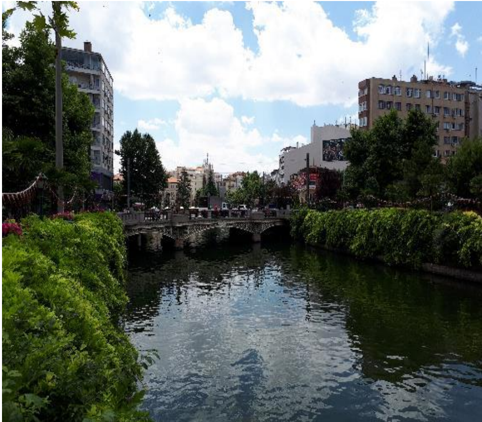
Şekil 1.63: Porsuk Çayı üzerindeki köprülerden bir görünüm, Eskişehir.
