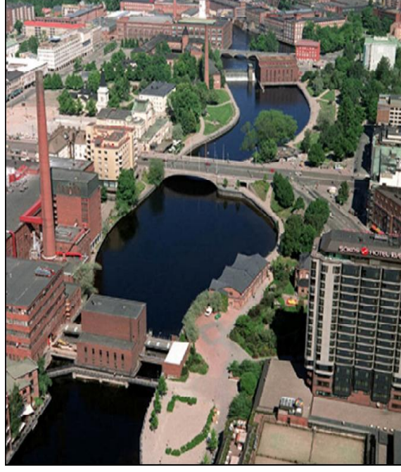
Şekil 1.8: Sanayii yapıları, Tampere, Finlandiya (Hattapoğlu, 2004).
