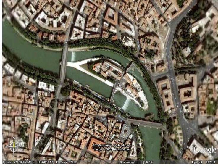
Şekil 1.13: Tiler Nehri, Roma'da ada geçişi (URL-4, 2018).
