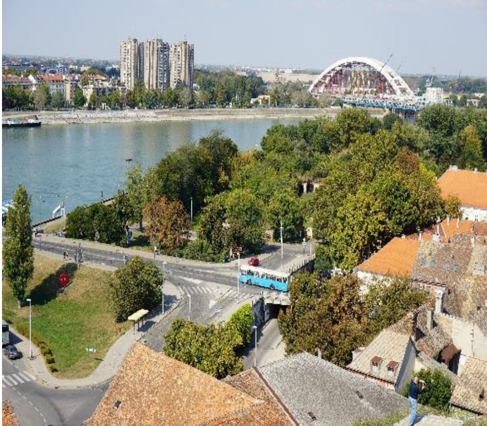
Şekil 1.33: Tuna Nehri üzerindeki farklı köprülerden bir görünüm.
