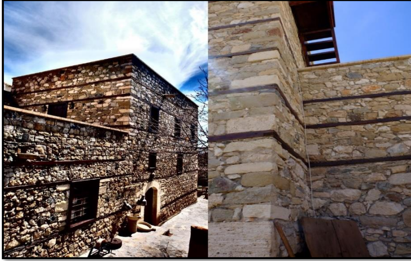
Şekil 4.42: Harput Evleri cephe düzeni (Görmüş, 2018).
