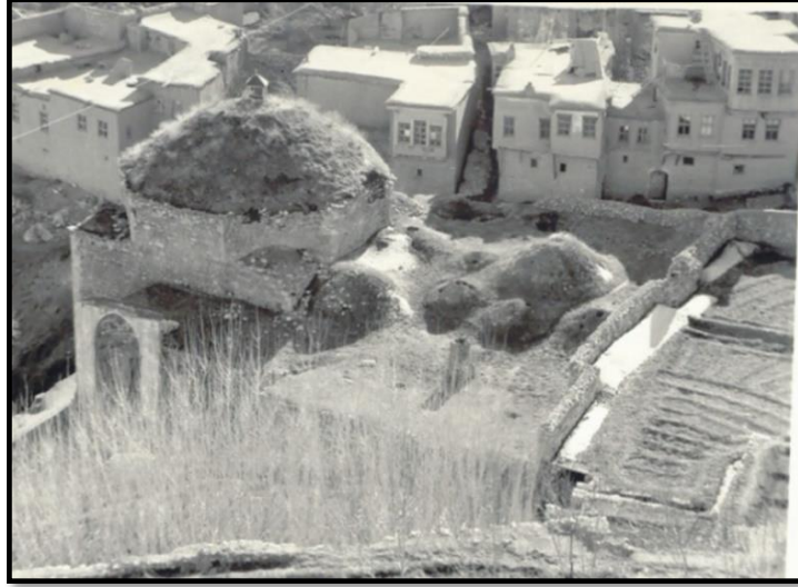
Şekil 4.27: Osmanlı döneminde Hoca Hasan Mahallesi (KUDEB, 2019).
