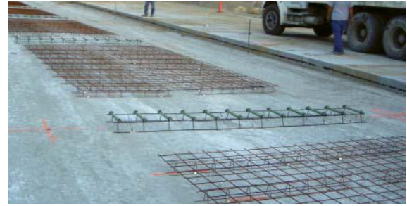
(b) Derzli Donatılı Beton Kaplama
