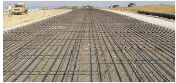
(c) Sürekli (Derzsiz) Donatılı Beton Kaplama
