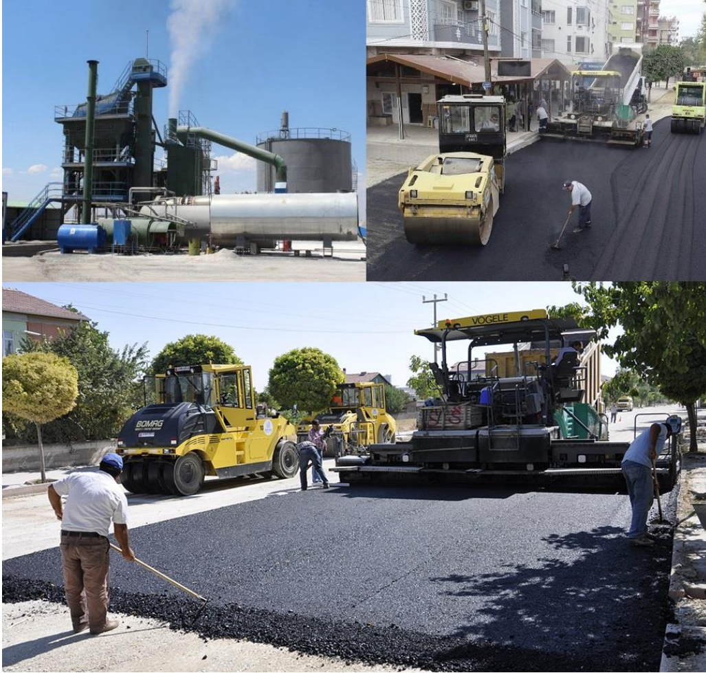
Şekil 2.3: BSK kaplama üretim ve yapım aşamaları (URL-1, 2017; URL-2, 2018; URL-3, 2019).
