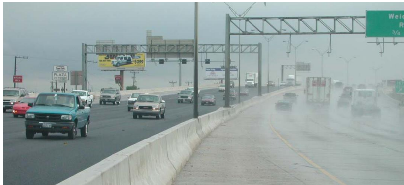
Şekil 3.1: Yağışlı havada geçirimli asfalt ile geleneksel asfalt kaplamalarda görüş mesafesi (Rand, 2011).
