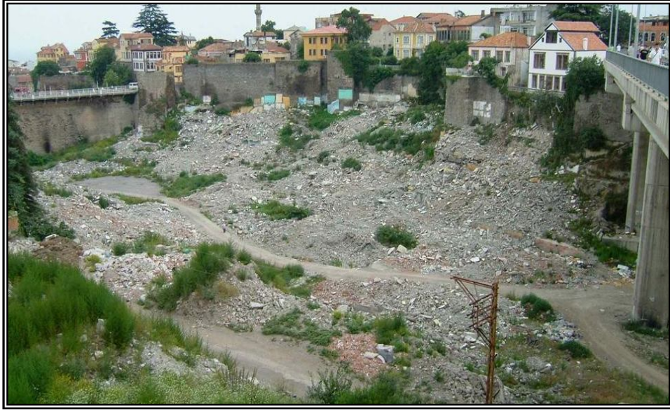
Şekil 2.55 Zağnos Vadisi gecekondu alanının yıkım aşaması (Anon. 2007).
