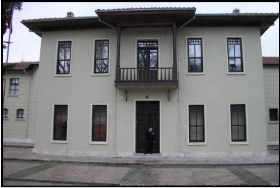
b. Park ve Bahçeler Müdürlüğü Binası (Fotoğraf: A. Cemil Tepe 2010).
