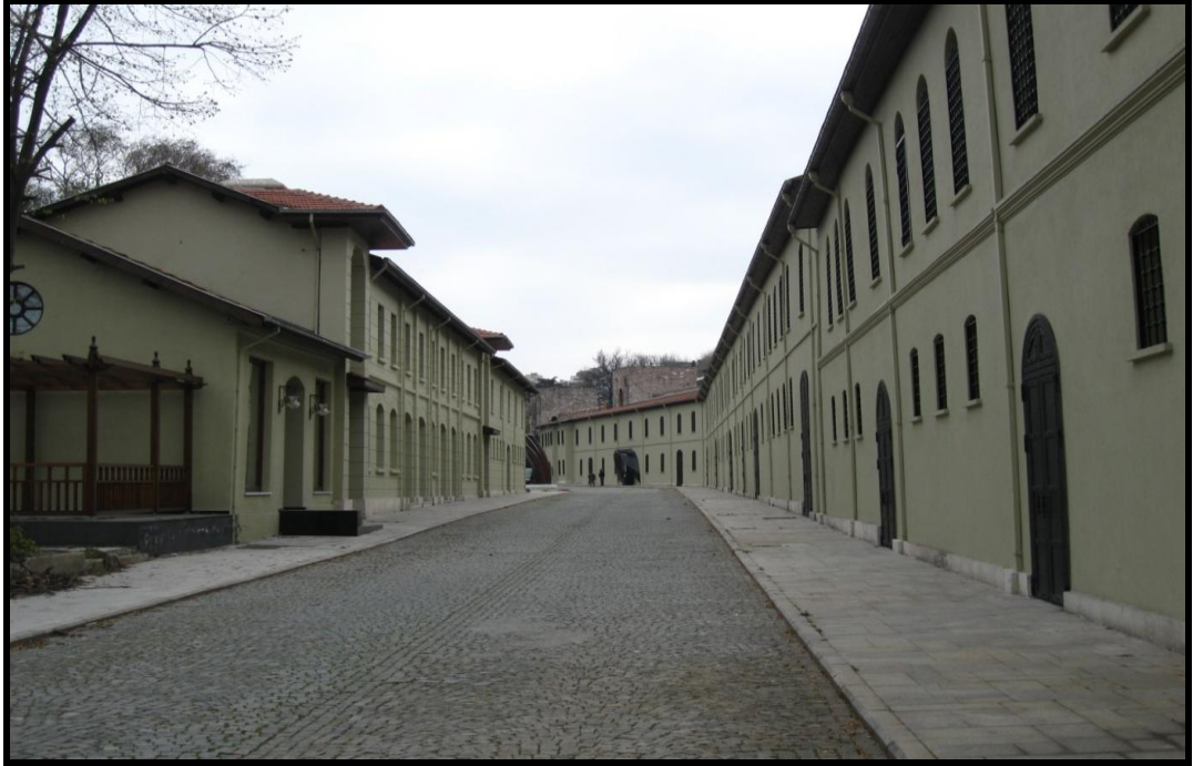
d. Ahır binalarının yenileme çalışmaları sonrası (Fotoğraf: A.Cemil Tepe 2009).
