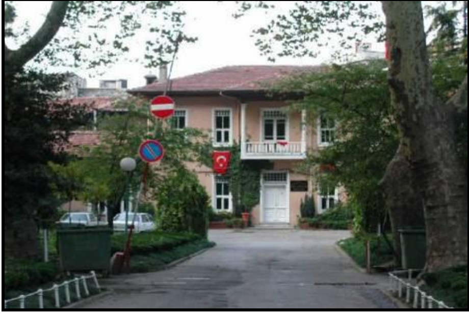
a. Park ve Bahçeler Müdürlüğü Binası (Fotoğraf: Zeynep Yılmaz 2000).
