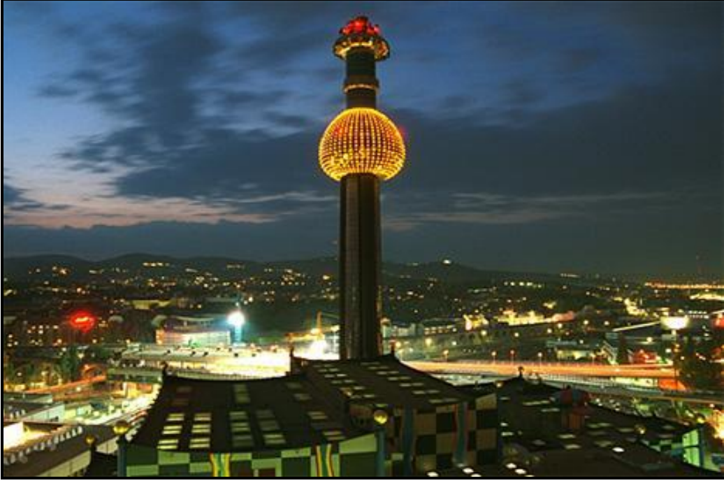
Şekil 2.17 Fiber optik aydınlatma tekniğiyle aydınlatılmış bir dış yapı örneği (URL-15 2009).
