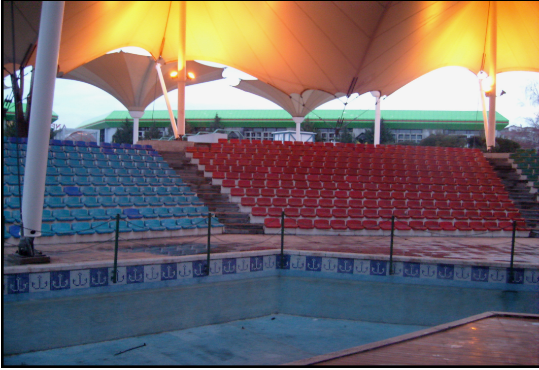
Şekil 5.24 Altınpark'taki amfi-tiyatronun aydınlatmasından bir görünüm (Fotoğraf: Fatih Yeniöglü 2009).
