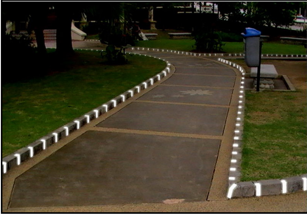
Şekil 2.37 Bir yaya yolu aydınlatması örneği (URL-22 2009).
