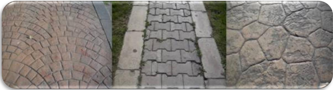
Şekil 4.26 Yürüyüş yollarındaki yüzey kaplamaları (Fotoğraf: Özlem Yüce Eşkil 2010).
