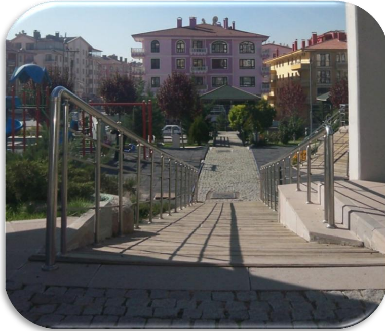
Şekil 4.70 Rampa örneği (Fotoğraf: Özlem Yüce Eşkil 2010).
