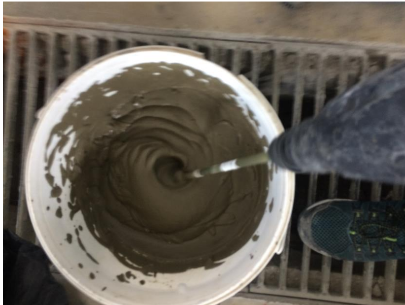
Şekil 3.12: Köpük beton harcının karılması.
