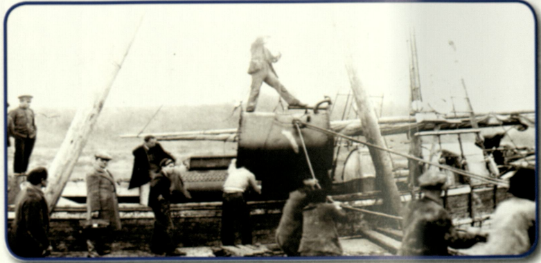
Foto 63: Bartın Elektrik Santrali Kazan ve boruları Yalı'dan indirilirken (1936)
