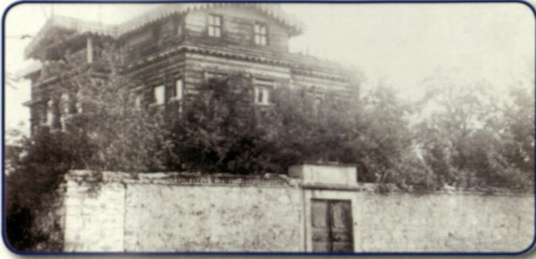
Foto 18: Bartın Ortaokulu (Bodosaki Konağı) (1925)
