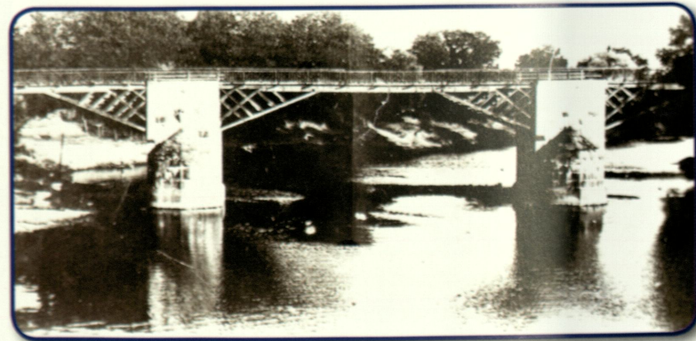
Foto 104: Bartın Orduyeri Köprüsü (1942)
