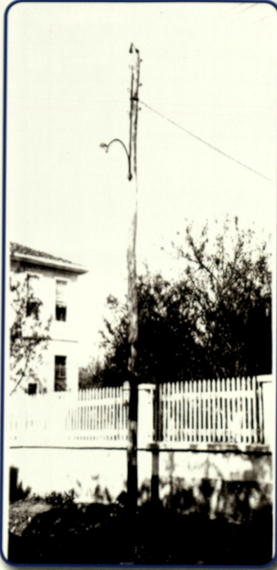
Foto 108: Bartın'da İlk Elektrik Direği (1936)
