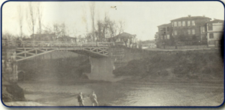
Foto 54: Bartın Asma Köprü (1957)
