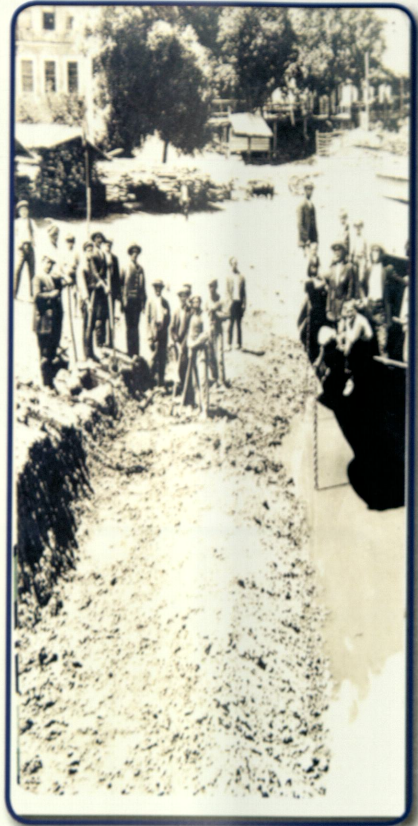
Foto 109: Bartın Yalı Senti Tahmil Tahliye İskelesi Yapılırken (1929)
