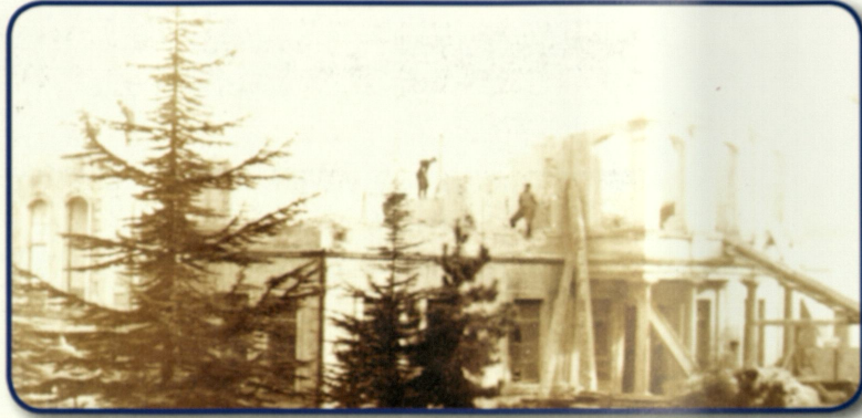
Foto 80: Bartın Eski Hükümet Binası Sökülürken (1969.)
