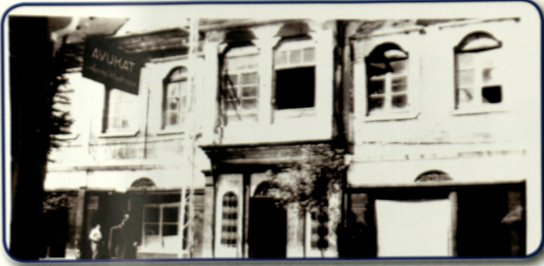
Foto 65: Bartın Eski Belediye Binası Restore Edilirken (1942)
