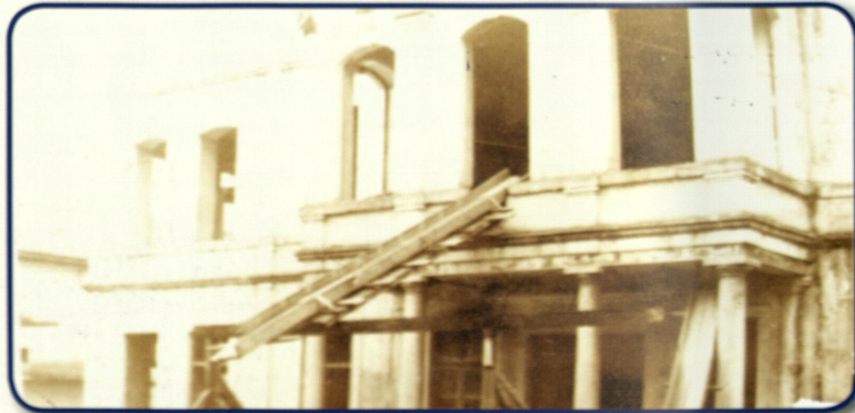
Foto 81: Bartın Eski Hükümet Konağı Sökülürken (1969)
