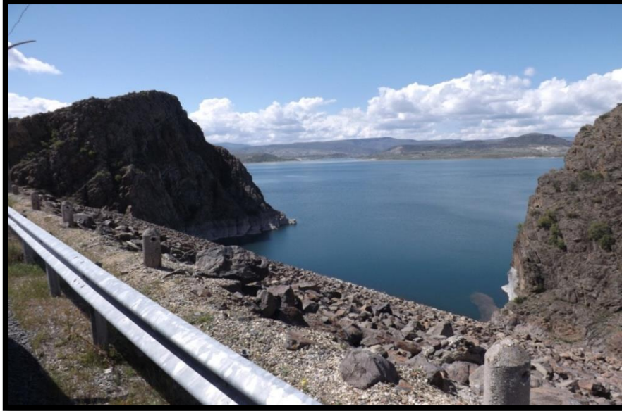
Şekil 34: Çamlıdere Barajı Bayındır Fayı.
