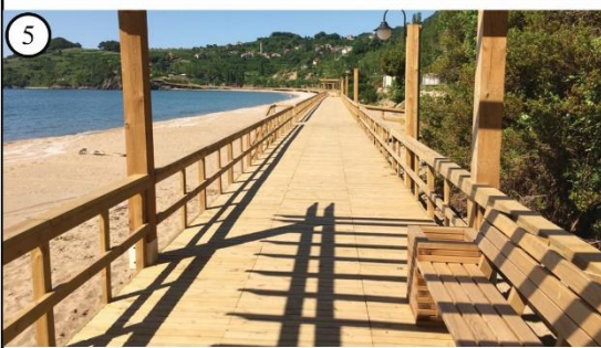
Güzelcehisar sahili, ahşap yürüyüş yolu ve peyzaj elemanları ilişkisi
