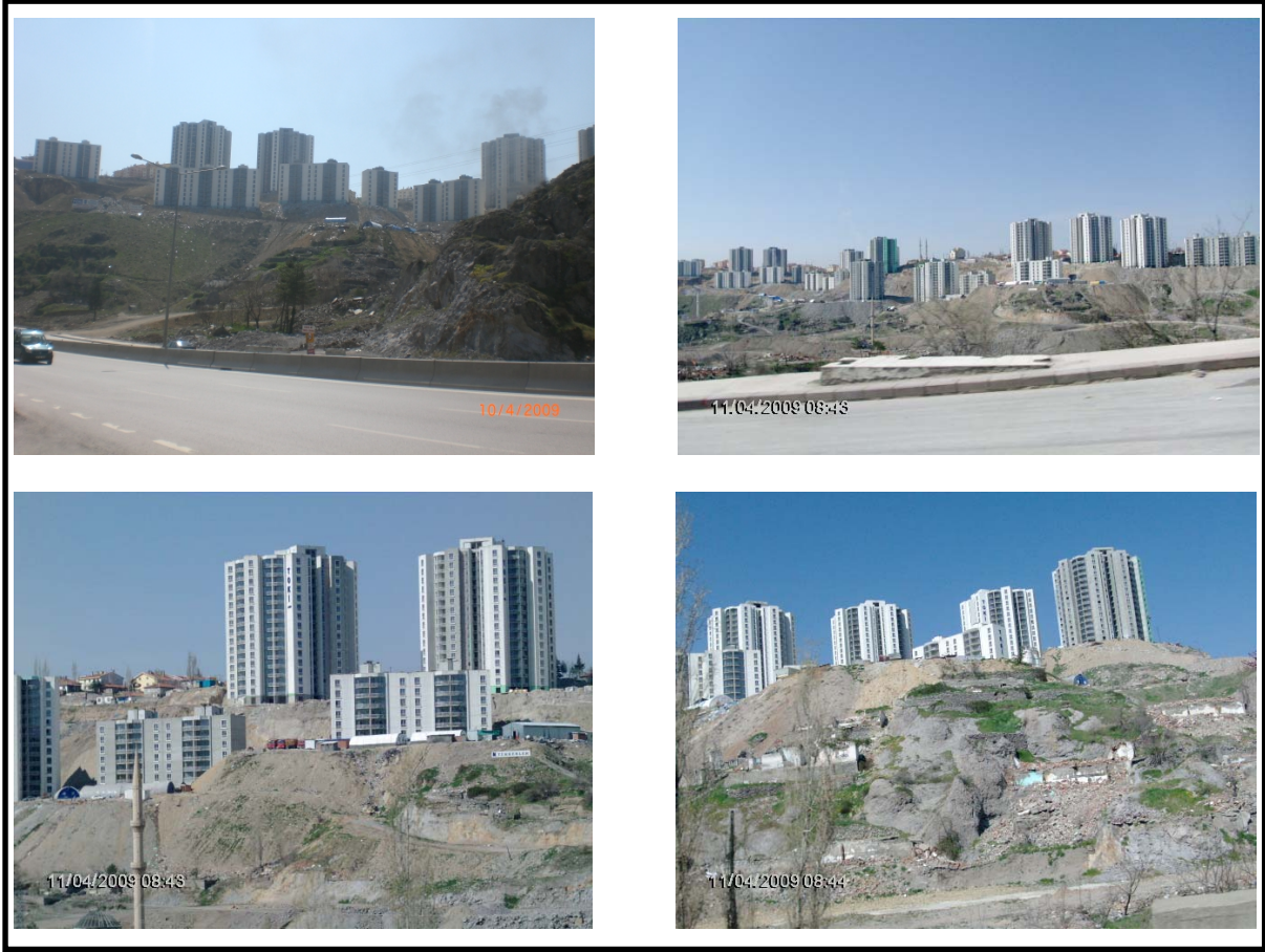
Şekil 4.8 2008 yılı proje alanındaki hak sahipleri konutlarının inşaat çalışmalarından görünüm (Fotoğraf: Esra Bayulu 2009).
