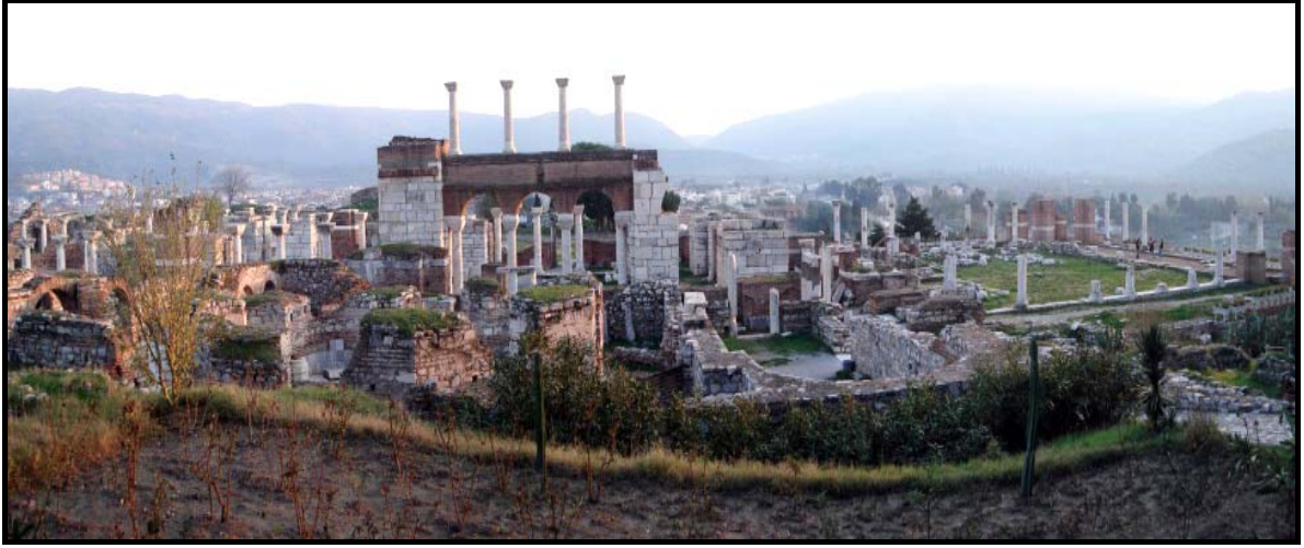
Şekil 4.21 St. Jean Bazilikası'nın bugünkü durumu (Fotoğraf: Gülşah Kaçmaz 2009).
