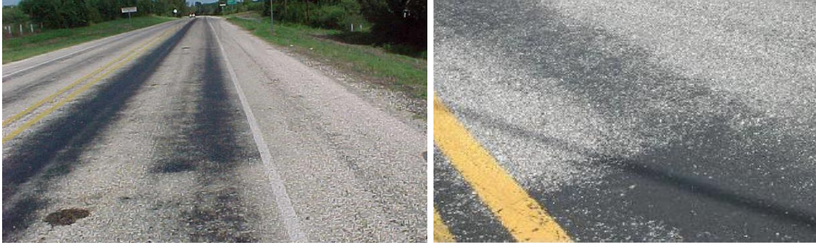
Şekil 2.5: Tekerlek izinde ve bölgesel terleme veya kuma
