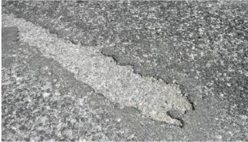
Şekil 2.4: Ayrışma bozulmasının tipik örneği
