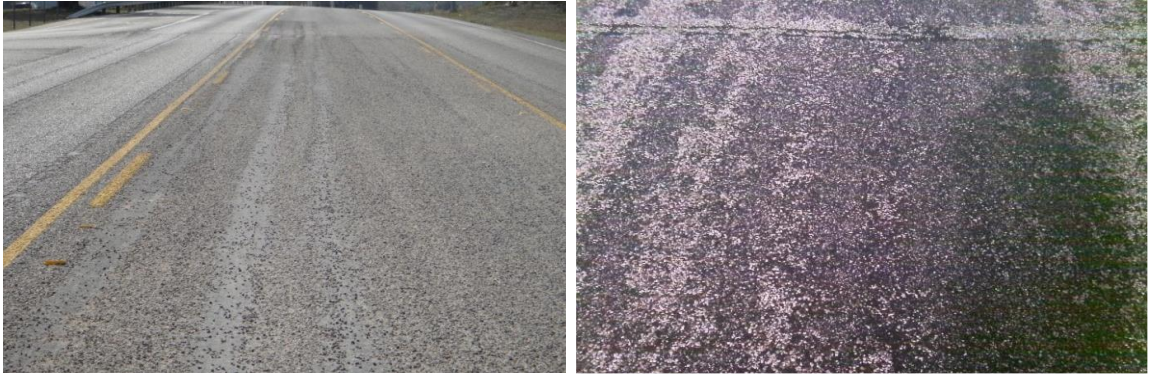
Şekil 2.6: Soyulma (agrega kaybı) sergileyen sathi kaplama yüzeyi
