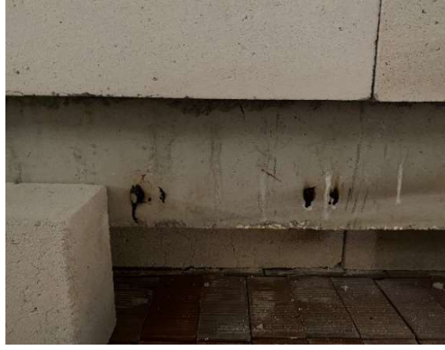
Şekil 3. 10: Numunelerdeki bozulmalar a) Soyulma-toz haline gelme-dökülme b) Su kaybı c) Çatlaklar d) Kararmalar
