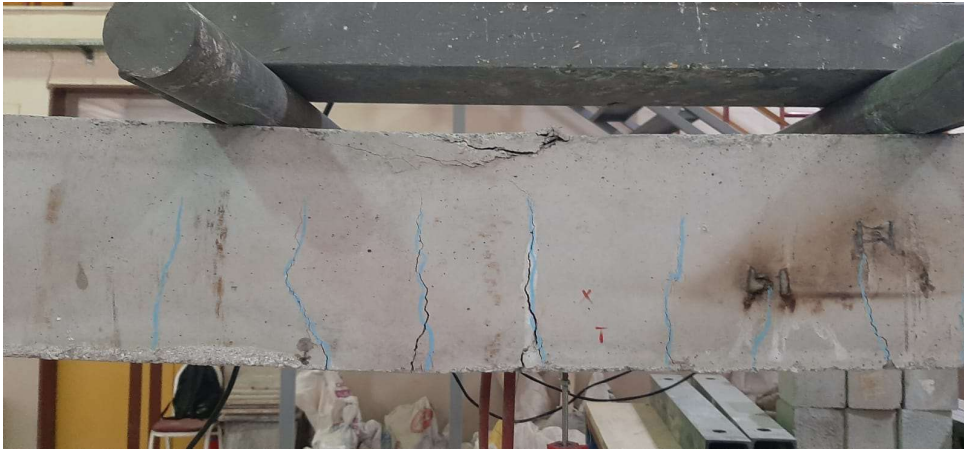
Şekil 4. 1: Referans elemanında meydana gelen eğilme çatlakları ve beton ezilmesi
