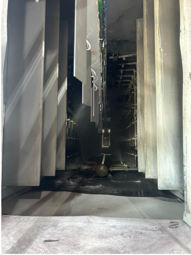
Şekil 4.5: Demir fosfat uygulaması
