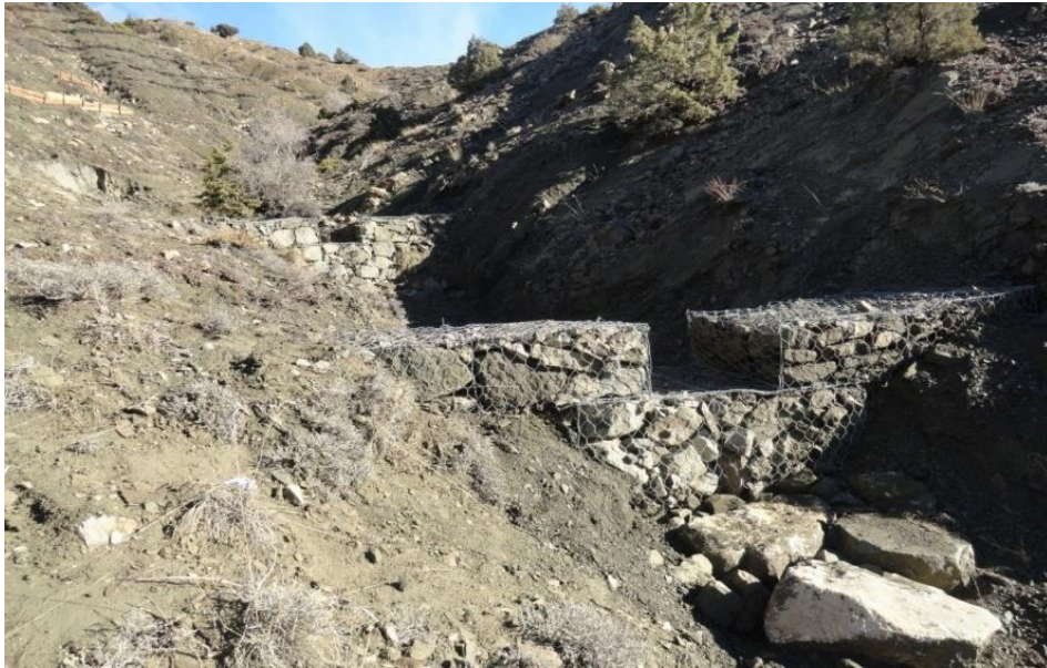
Şekil 1.18: Çalışma alanına ait gabion eşik örneği
