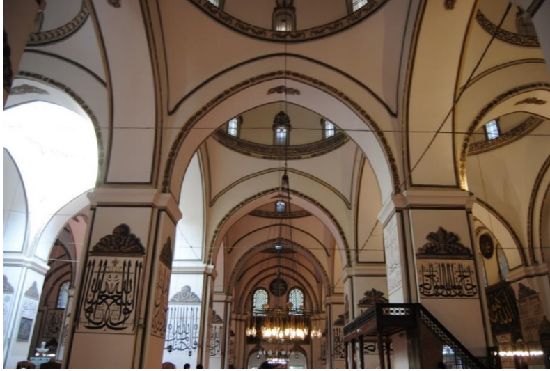
Şekil 4: Taşıyıcı ayaklar, sivri kemerler ve pandantifler
