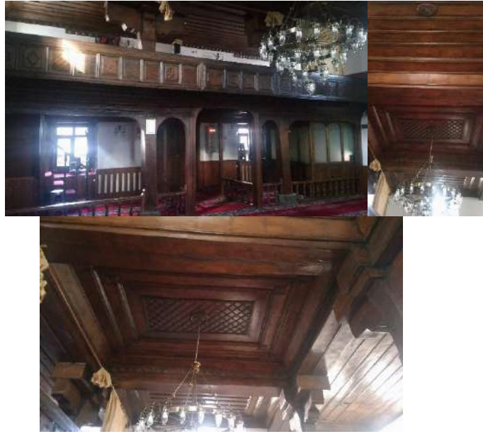
Şekil 8. İhmal Camii restorasyon sonrası görüntüleri
