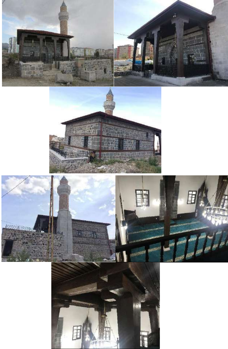
Şekil 16. Tahta Camii restorasyon sonrası görüntüleri
