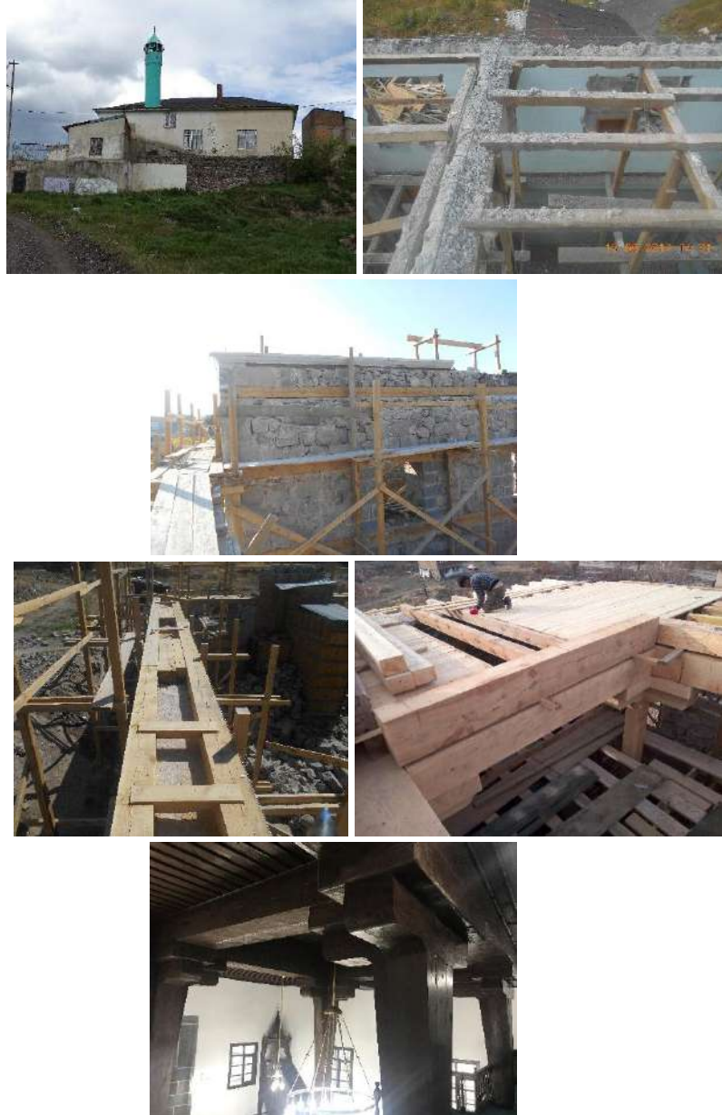
Şekil 15. Tahta Camii restorasyon aşamalarına ait görüntüler
