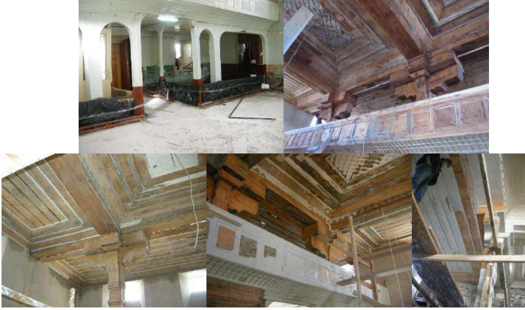
Şekil 7. İhmal Camii restorasyon aşamalarına ait görüntüler
