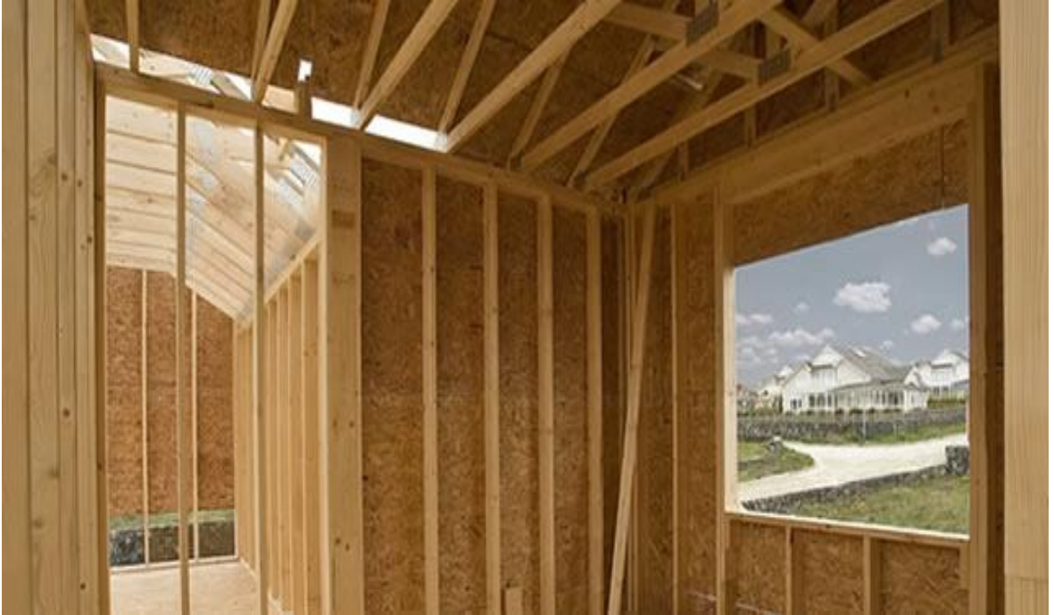
Şekil 6: OSB'nin bina yapımında kullanılması (URL-3, 2015)
