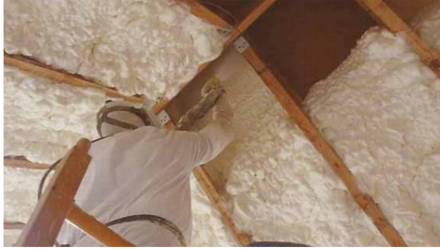
Şekil 1.6 Poliüretan köpük uygulaması (Bursa vana ceketi, 2017).
