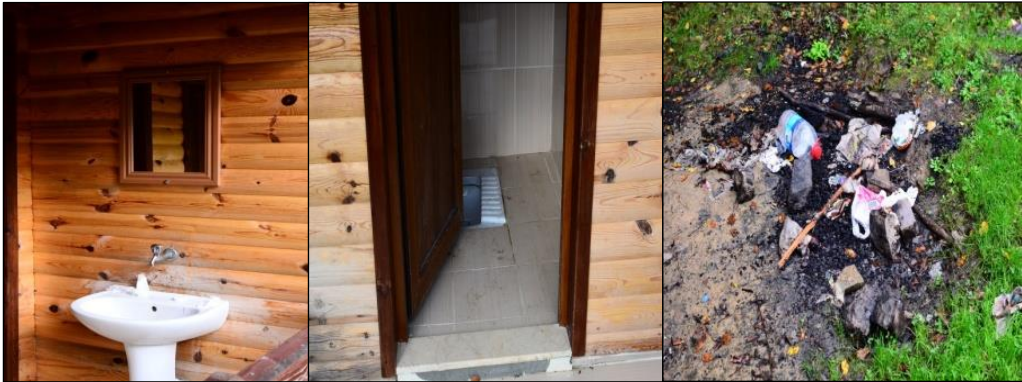
Şekil 44: Zonguldak Kent Ormanı'ndaki tuvaletlerin durumu ve ateşli piknik izi.
