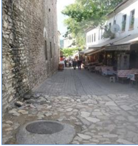
Şekil 34: DMA Safranbolu Çarşı'da alt yapı çalışmaları sonrası tarihi doku ile uyumsuz yer döşemelerine ait görünüm (Fotoğraf: Çiğdem BOGENÇ 2011).
