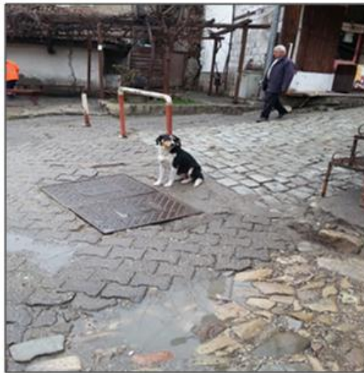
Şekil 25: Tarihi Çarşı'da çökmüş arnavut kaldırımları ve arnavut kaldırımlar ile uyumsuz döşeme örnekleri (Fotoğraf: Çiğdem BOGENÇ 2016).
