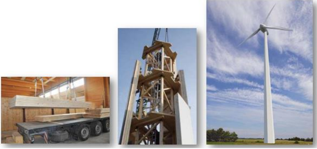
Şekil 14: Glulam ve ÇLK kullanarak üretilmiş rüzgar gülü örneği (Wallwork, 2012).
