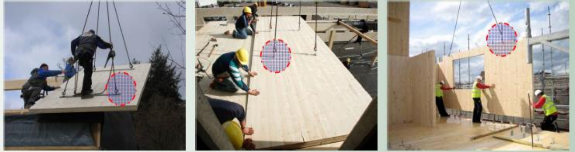
Şekil 9: ÇLK montaj aşamasına örnek (Schickhofer, 2011).
