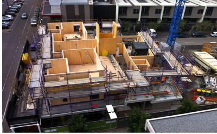
Şekil 12: ÇLK panellerle yapılmış Forte binasının yapım aşaması (Güzel ve Yesügey, 2015).
