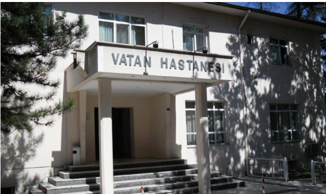
Şekil 22. Yenişehir Vatan Hastanesi
