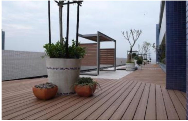
Şekil 7: Odun plastik kompozit malzemenin yer döşemesi olarak kullanımını (URL-1, 2014).
