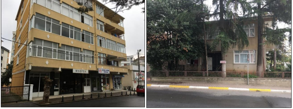
Şekil 4.14: İlim Caddesi üzerindeki eski yapılara ait cephe ve bahçe görünümleri (Orijinal, 2019).
