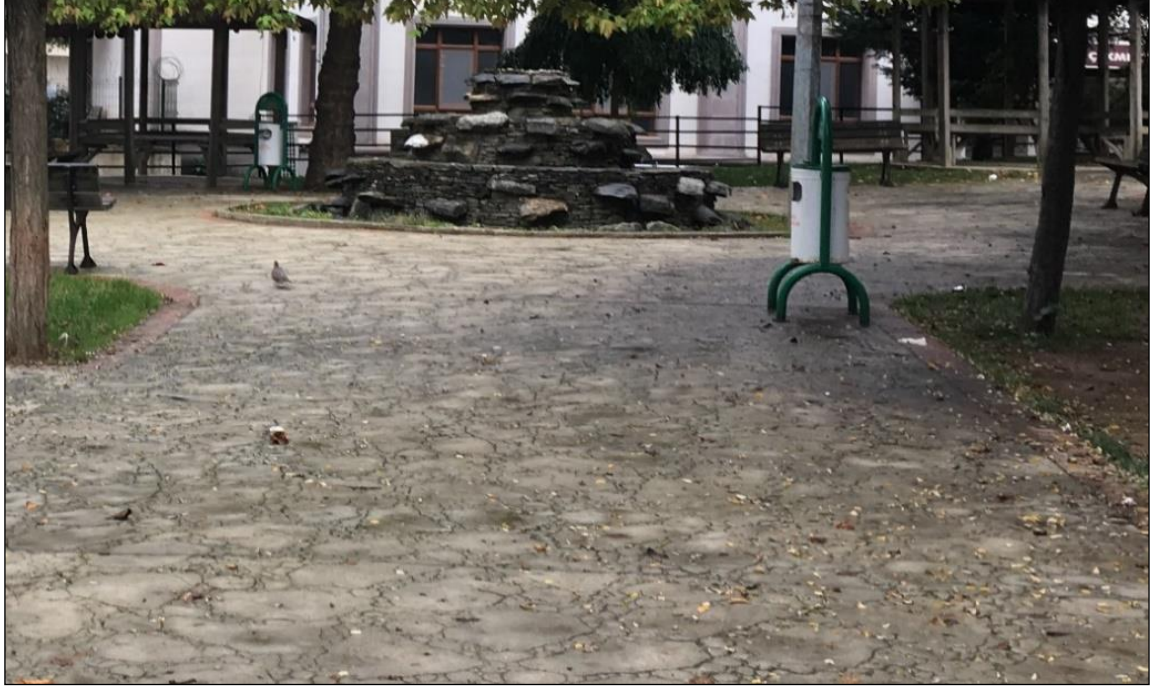
Şekil 4.41: Parklarda zemin döşemesi olarak kullanılan baskı beton kaplaması (Orijinal, 2019).
