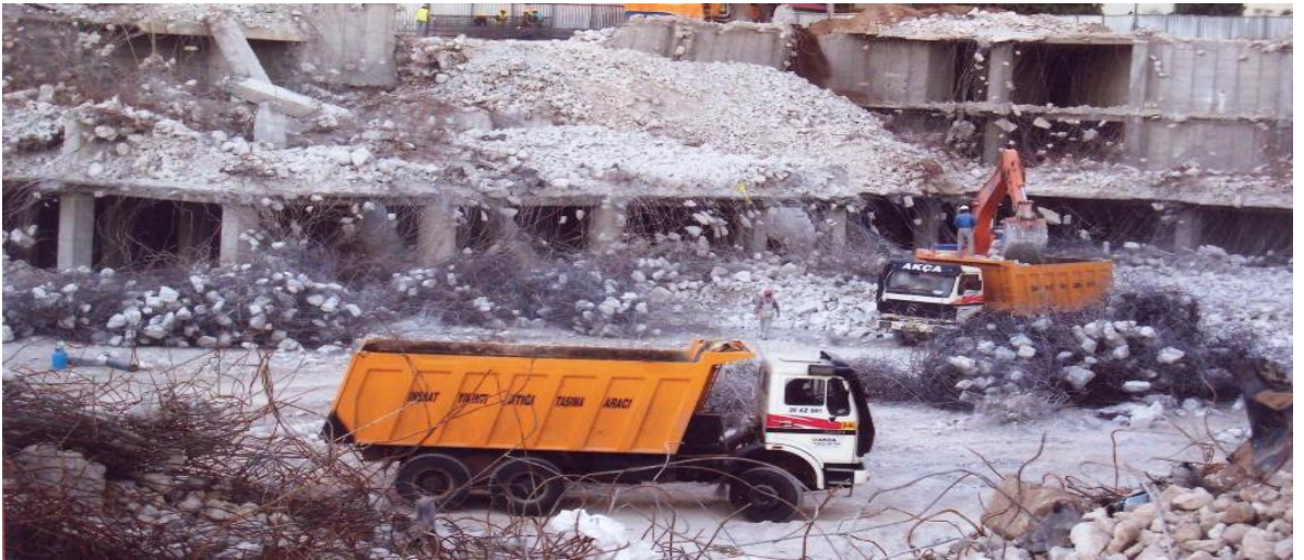
řekil 2.4: İnřaat yıkıntılarının geri dönüşüm tesisine nakliyesi.
