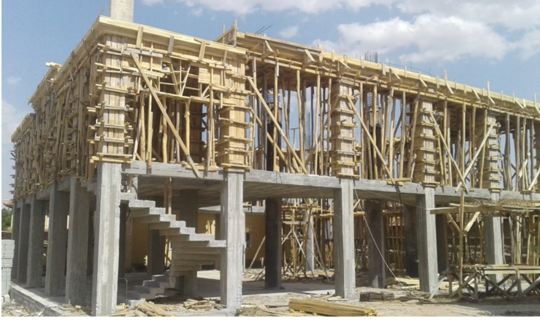
Şekil 1.17: Ahşap Kalıp Sistemi İle İnşa Edilen Yapı (URL-6,2020) .
