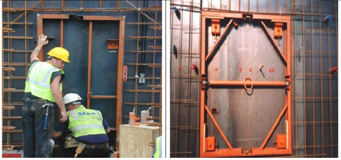
Şekil 1.13: Tünel Kalıp Yapımında Ek Parça Örnekleri (Kıncal, 2006).
