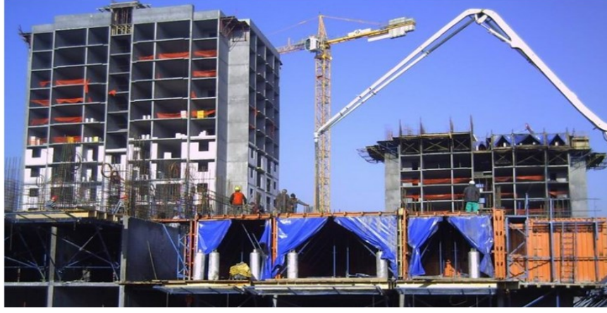
Şekil 1.16: Tünel Kalıpta Kırleme (Kıncal, 2006).
