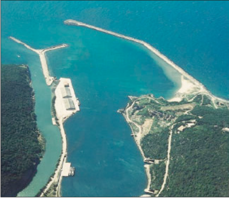
Fotoğraf 12: Limanın, İnşaatın Tamamlanmasından Sonraki Hâli.
