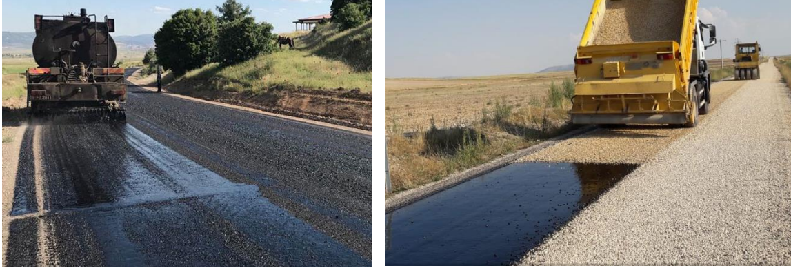
Şekil 2.6: Sathi kaplama yapım aşamaları (Marastanhaber, 2018; Dinçel, 2018)
