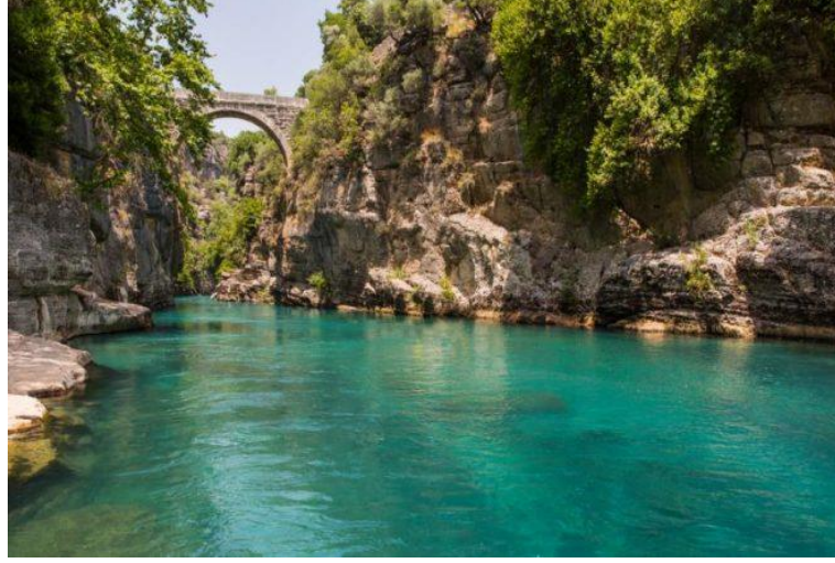
Şekil 2.36: Köprülü Kanyon, Antalya Köprü Görünüşü (URL-9, 2019)
