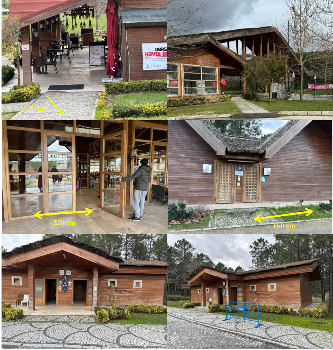
Şekil 4.3: Bina girişlerine ait rampalar.
