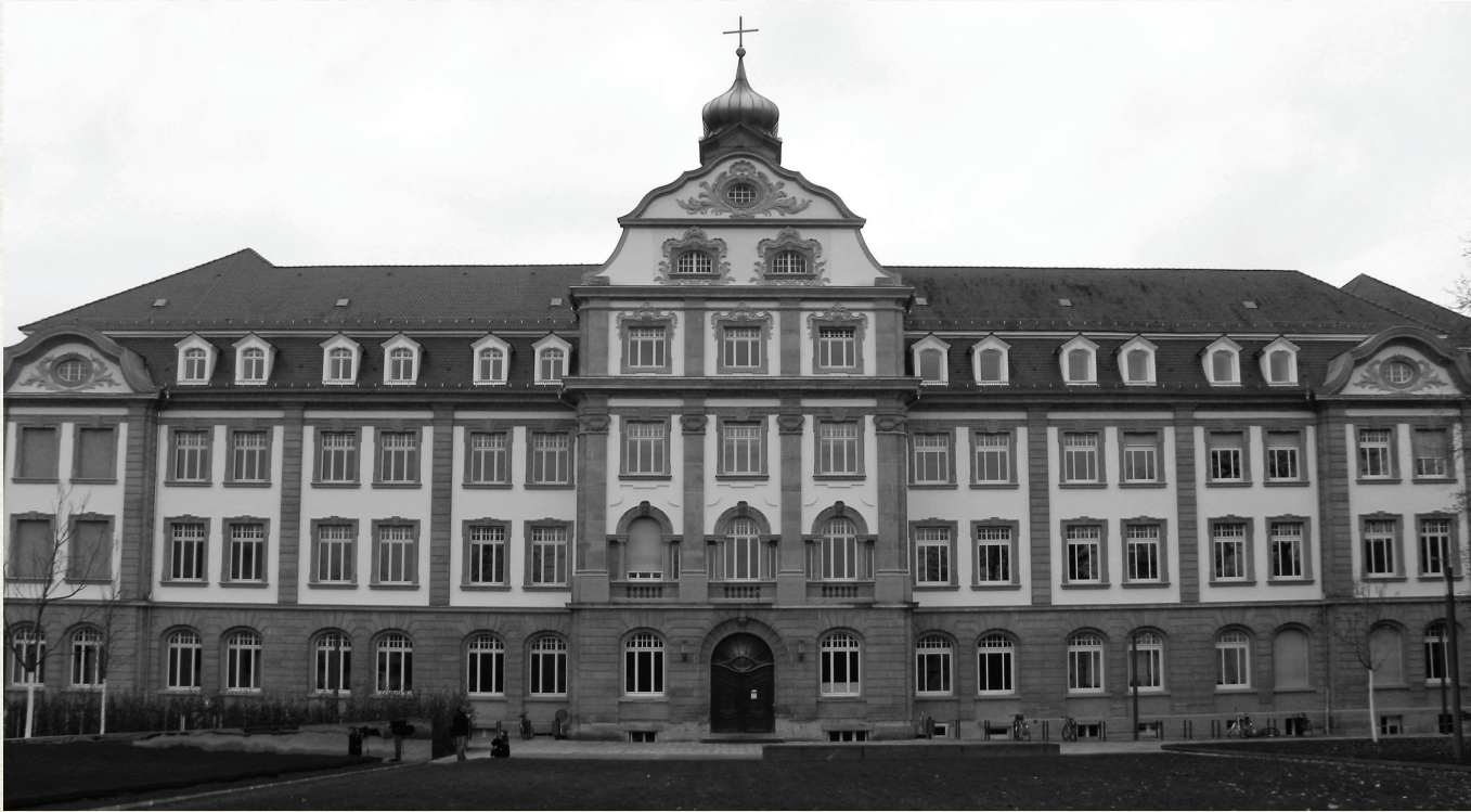
Karlsruhe (Technische Hochschule) Teknik Üniversitesi
