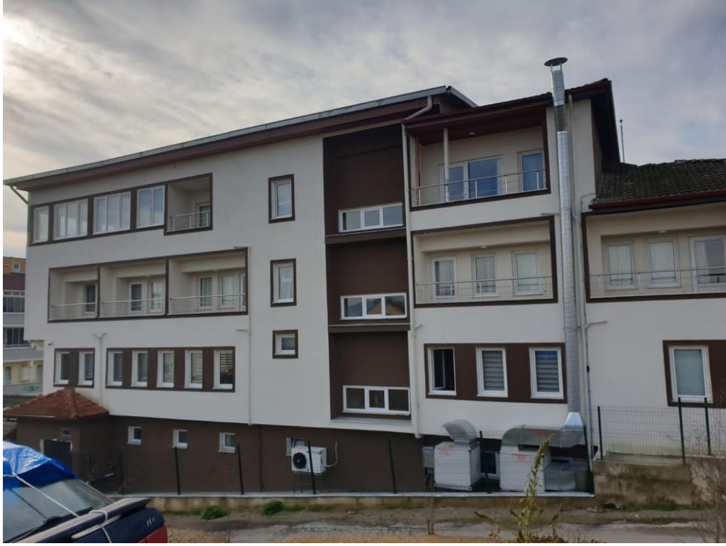
Şekil 4.11: Huzurevinin kuzey cephesi (2022)
