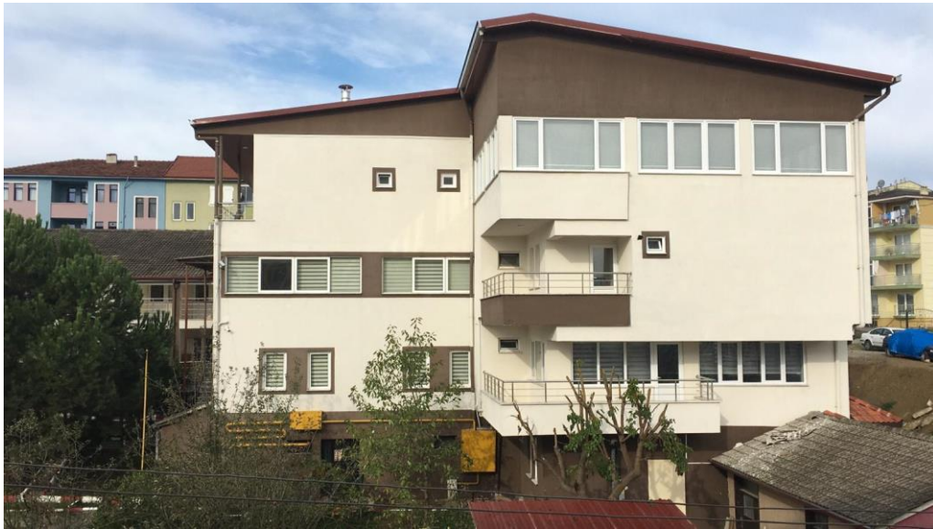
Şekil 4.10: Huzurevinin doğu cephesi (2022)
