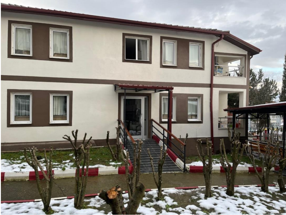
Şekil 4.14: Bina giriş rampası (2022)
