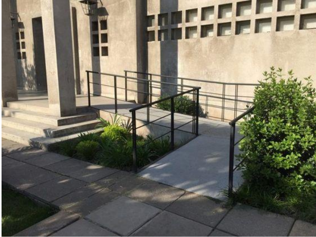
Şekil 5.2: Bina giriş rampası örneği-2 (Anonim, 2022)
