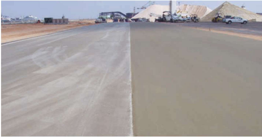
Şekil 3.13: SSB tabakada oluşturulan boyuna derz
