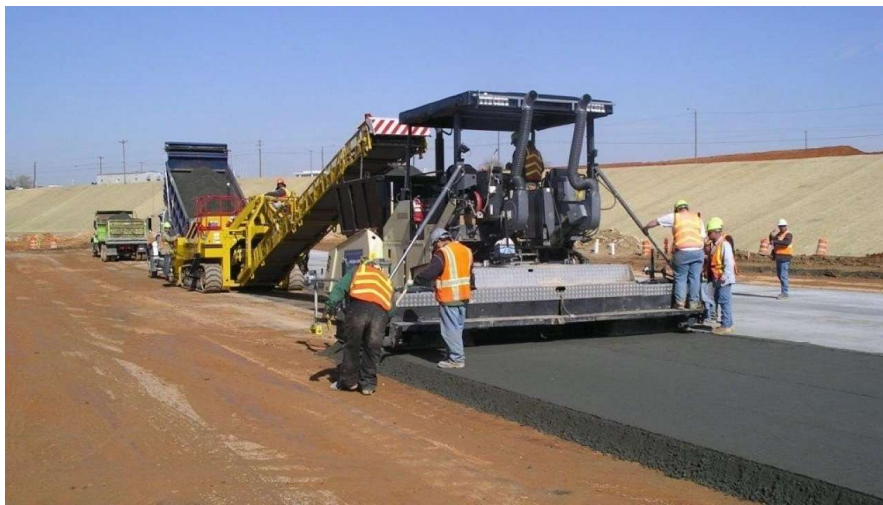
Şekil 3.10: SSB karışımının finişer ile serilmesi
