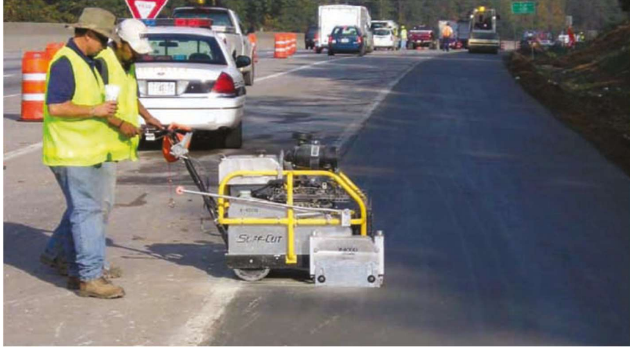
Şekil 3.12: SSB tabakada enine derz kesilme işlemi
