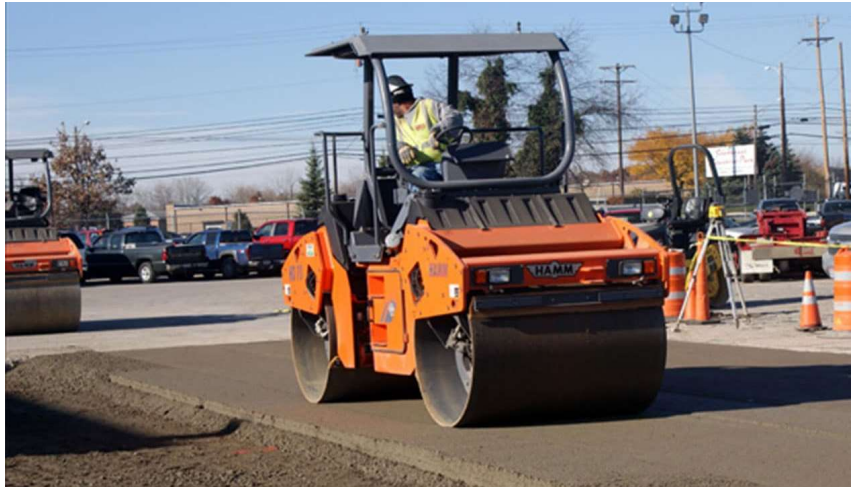
Şekil 3.11: SSB karışımının çift tamburlu titreşimli silindirler ile sıkıştırılması
