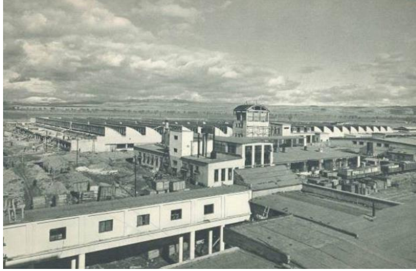
Şekil 2.4: Kayseri Sümerbank Beş Fabrikası (URL-4, 2021).
