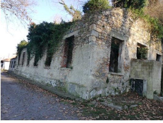
Şekil 4.12 Aşağı kandilli eski okul binası
