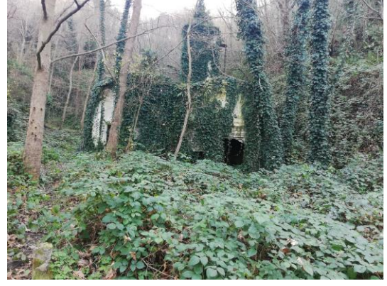
Şekil 4.13 Aşağı kandilli kilise binası
