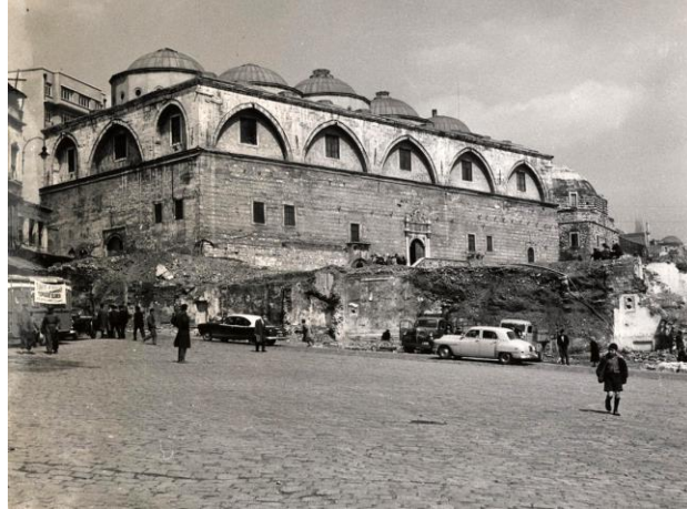
Şekil 2.6: İstanbul Tophane-i Amire binası (URL-6, 2021).
