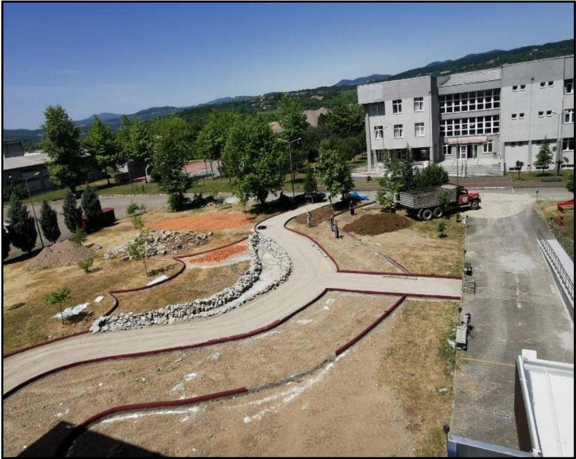
Şekil 4.25: Yürüme yolu ve sebze parseli yapım çalışması (Orijinal, 06.05.2022).
