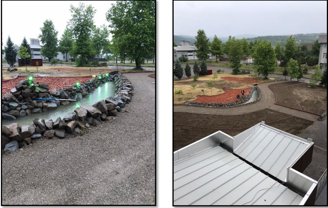
Şekil 4.29: Altyapı ve ışıklandırma çalışmaları (Orijinal, 08.06.2022).
