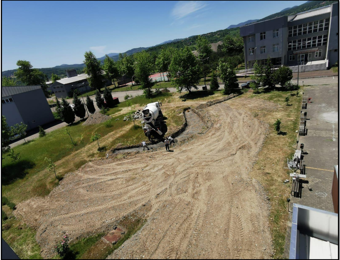
Şekil 4.21: Gölete beton dökümüne ait görünüm (Orijinal, 21.05.2022).
