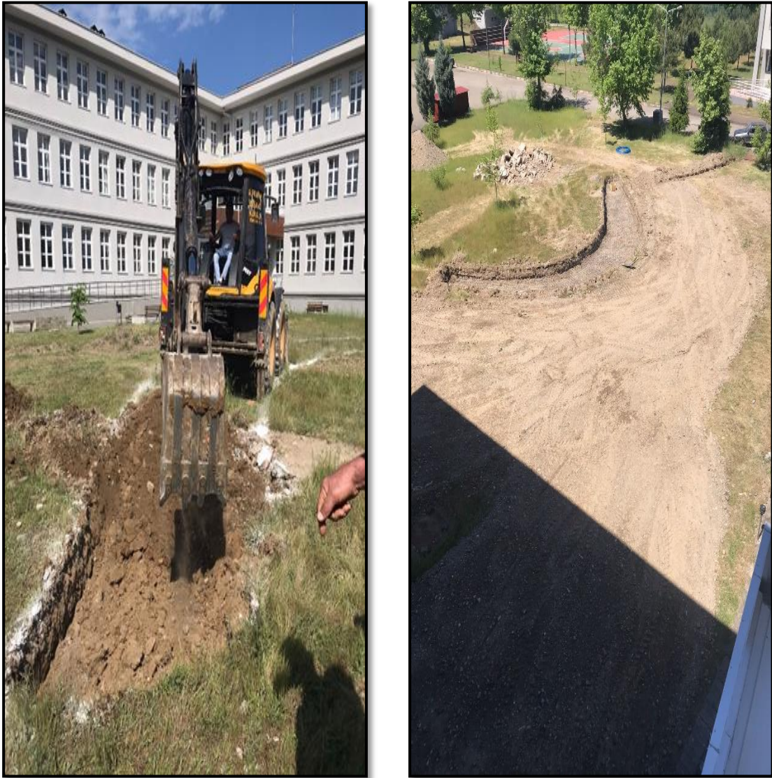
Şekil 4.20: Göletin çizimi ve kazımı (Orijinal, 19.05.2022).
