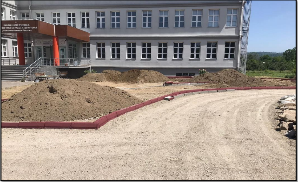
Şekil 4.26: Toprak getirme ve tevsiye işlemleri yapma (Orijinal, 07.06.2022).
