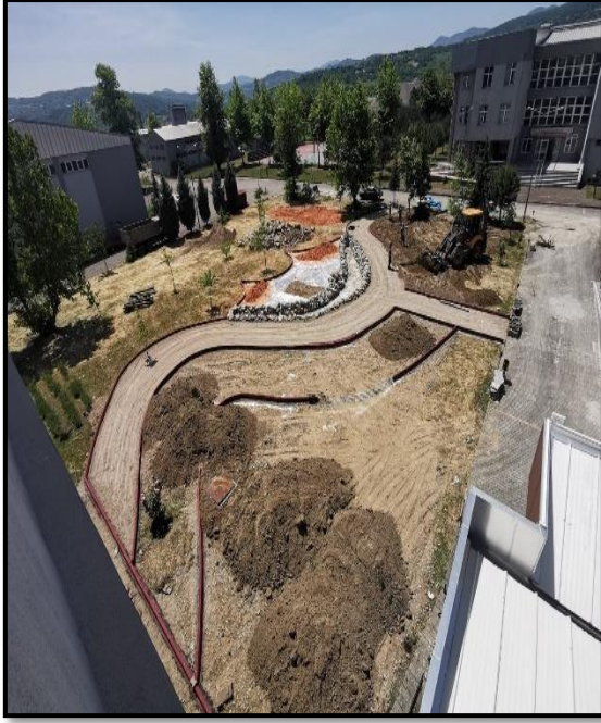
Şekil 4.27: Toprak getirme ve tevsiye işlemi yapma (Orijinal, 07.06.2022).
