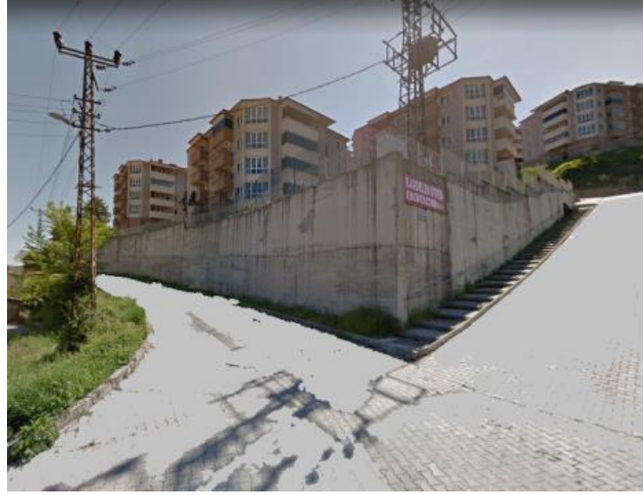
Şekil 4.47: Bartın Gölbucağı mahallesi istinat duvarları
