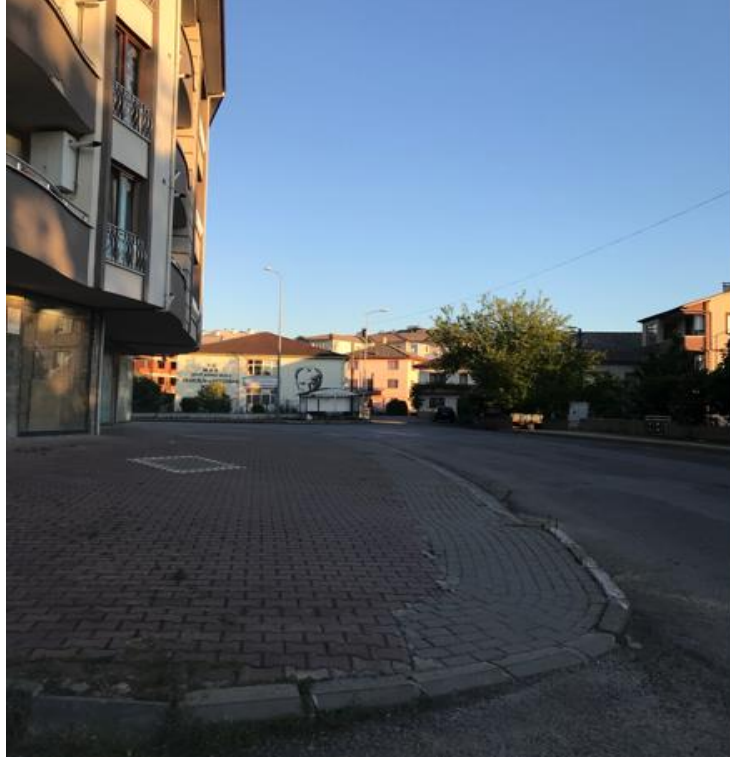
Şekil 4.40: Bartın Aladağ mahallesi mevcut gri altyapının hakim olduğu bir görünüm
