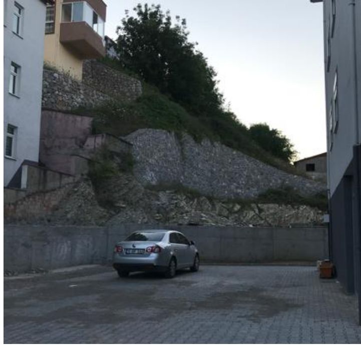
Şekil 4.45: Bartın Aladağ mahallesi istinat duvarları
