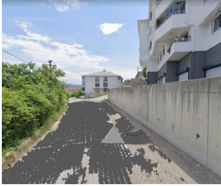
Şekil 4.48: Bartın Aladağ mahallesi yeni yapılaşma sonucu mevcut yeşil alanların gri altyapıya dönüşümü
