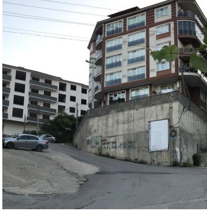
Şekil 4.46: Bartın Cumhuriyet mahallesi istinat duvarları
