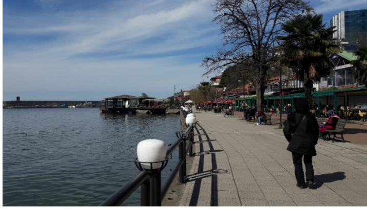
Şekil 4. 65: Su kenarındaki aydınlatma ögeleri (Şahin, 2022).
