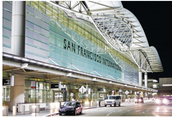
Şekil 2. 15: San Francisco'daki T2 Havaalanı (URL-11, 2015).
