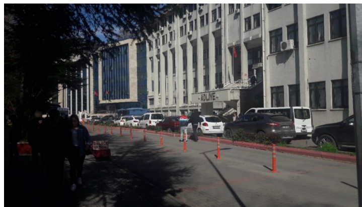
Şekil 4. 112: Adliye binası ve çevresinden bir görünüm (Şahin, 2022).
