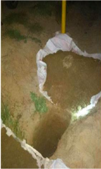
Şekil 3.5 Hindistan'daki bir boru hattında tespit edilip durdurulan kaçak kazı ve kaçak musluk (Berlin Pipeline Technology Conference, 2020).
