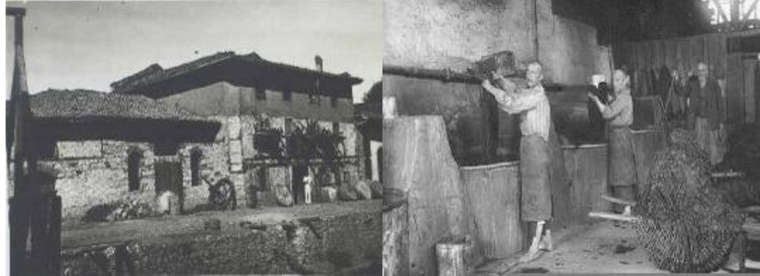
Şekil 2,3. Çalışma alanının önceki durumuna ait görünüm (Uşak Belediyesi, 2010)
