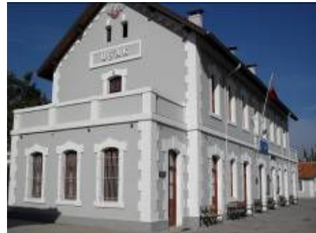
Şekil 5. Uşak tarihi tren garı binası
