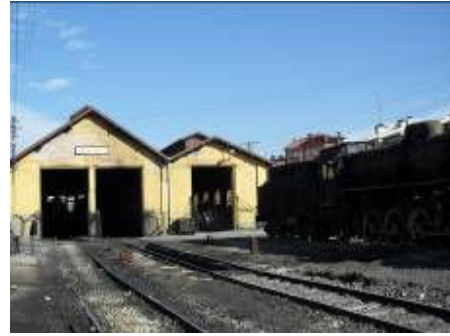
Şekil 9. Uşak tren garında farklı amaçlara hizmet edebilecek açık ve kapalı mekanlar
