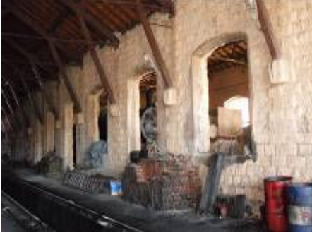
Şekil 7. Uşak tren garı alanında farklı amaçlara hizmet edebilecek restore edilmemiş yapılardan bir görünüm
