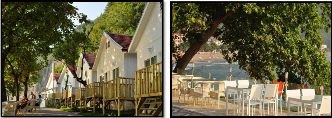
Şekil 3.48: İnkum Muhafaza Ormanı tesisler.
