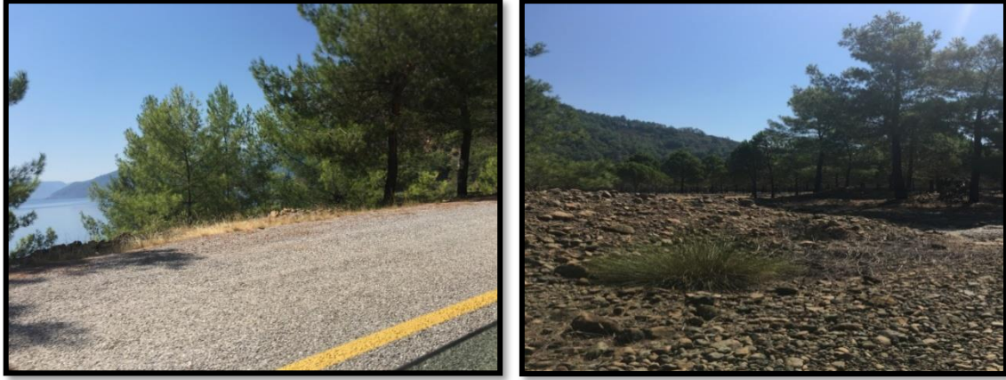
Şekil 3.1: Aksaz-Karaağaç Muhafaza Ormanı.
