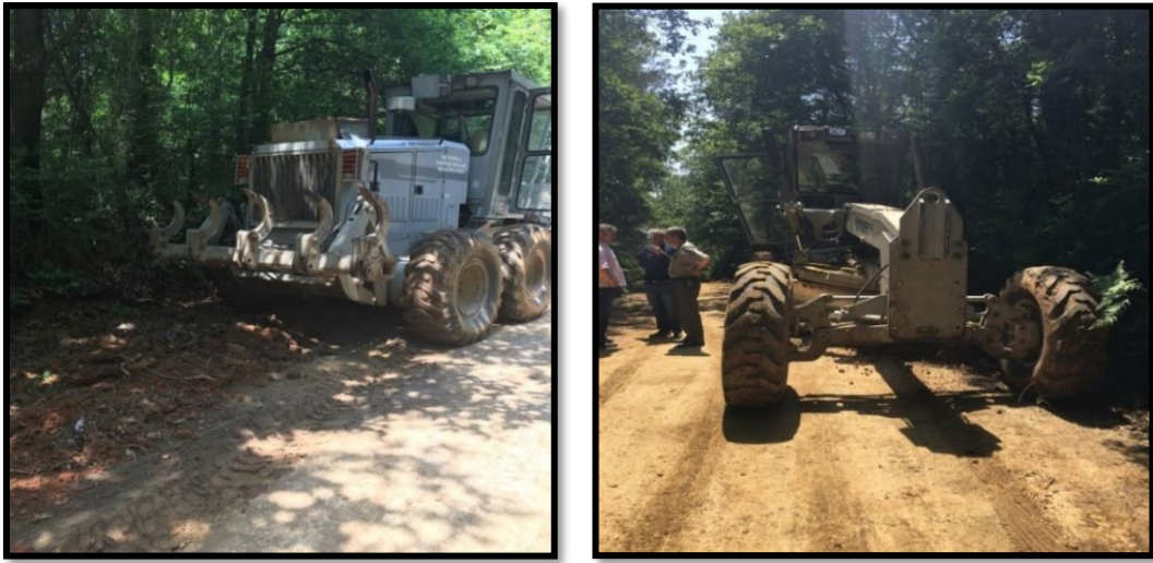
Şekil 3.24: Belgrad Muhafaza Ormanı Kurtkemerli sınırı yangın emniyet yol çalışması.
