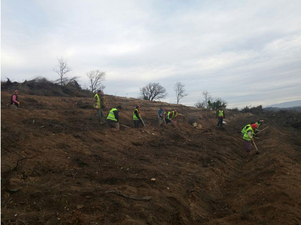
Şekil 2.2 Kesikli terasların yapılması
