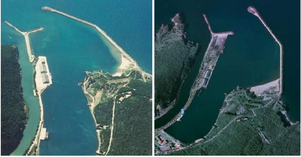
Şekil 10: Bartın Limanı'nın Tamamlanmış Hali ve Bartın Limanı Mevcut Rıhtım
