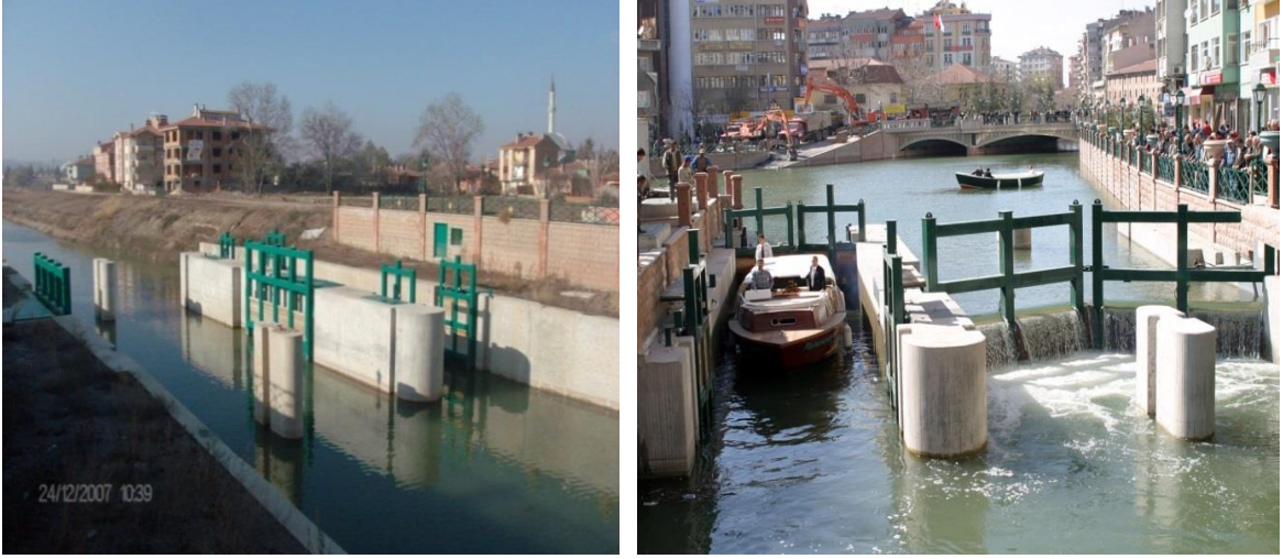
Şekil 34:Porsuk Çayı'nda Su Seviye Kontrol Yapıları
