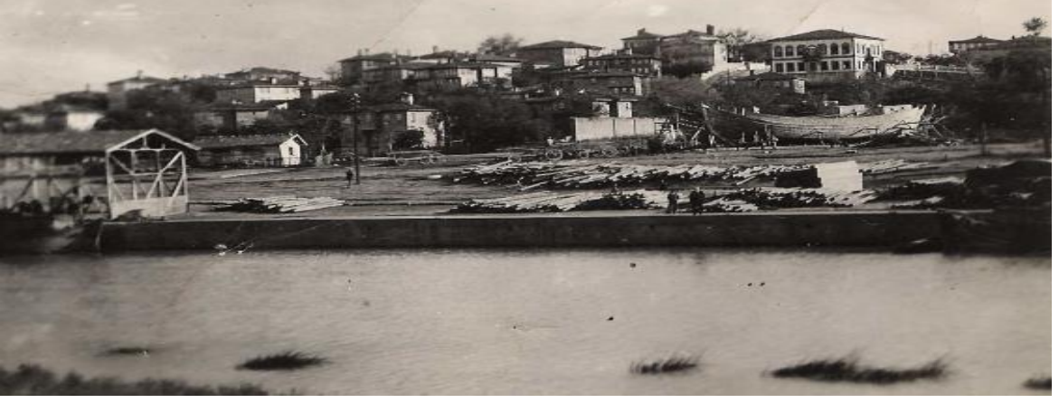
Şekil 8: Bartın Limanı İnşa Edilmeden Önce Bartın Irmağı
