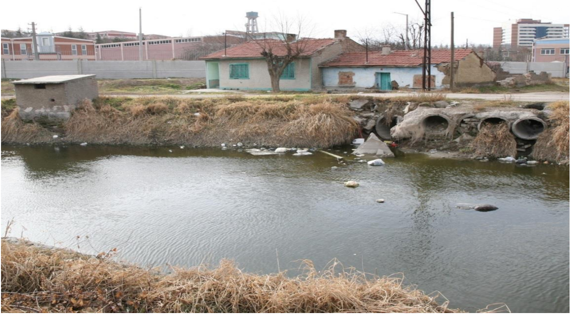
Şekil 33: Porsuk Çayı'nda Bulunan Eski Sulama Kanalları
