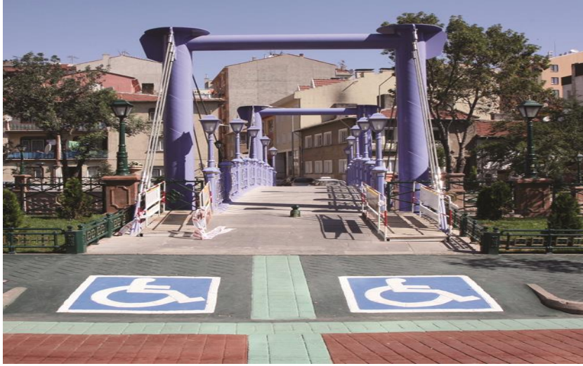
Şekil 36: Porsuk Çayı Üzerinde İnşa Edilen Örnek Köprü
