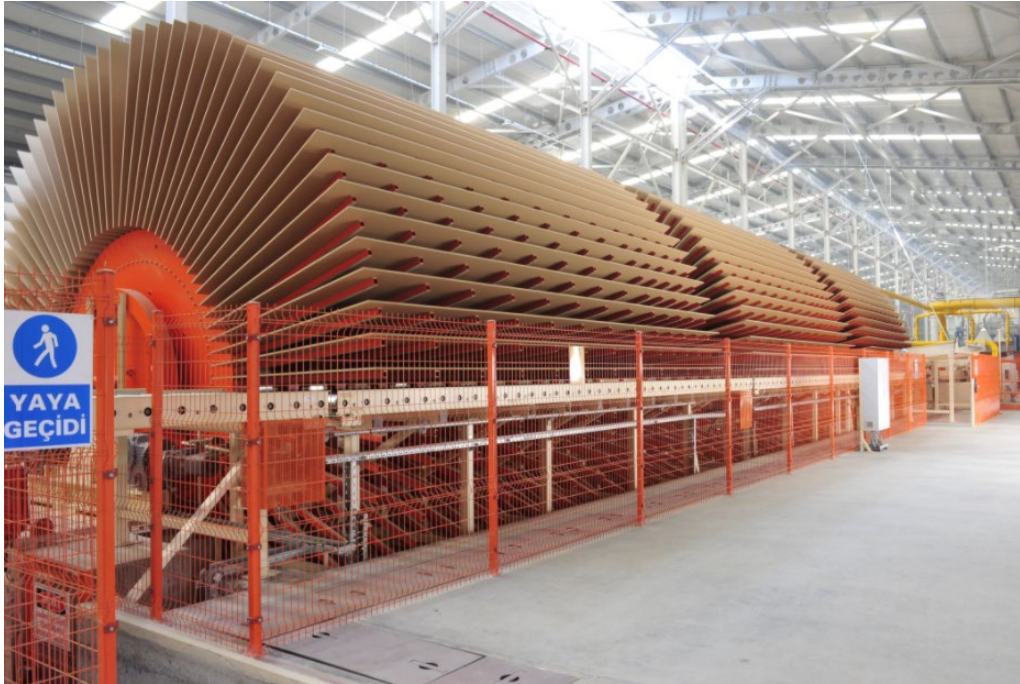
Şekil 1.64: Yıldız Soğutma Ünitesi (URL-43, 2017)
