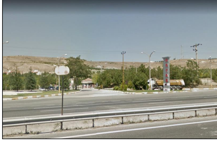
Şekil 3.31: Araştırma alanında yer alan BOTAŞ tesislerinden bir görünüm.
