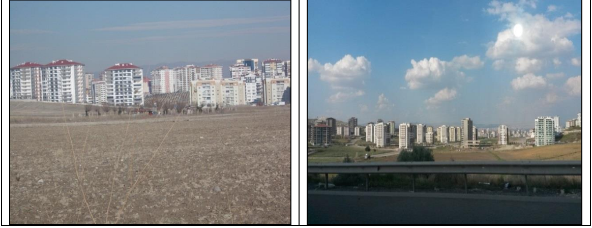
Şekil 3.22: Bağlıca Yerleşimi'ndeki çok katlı toplu konut alanlarından görünümeler.
